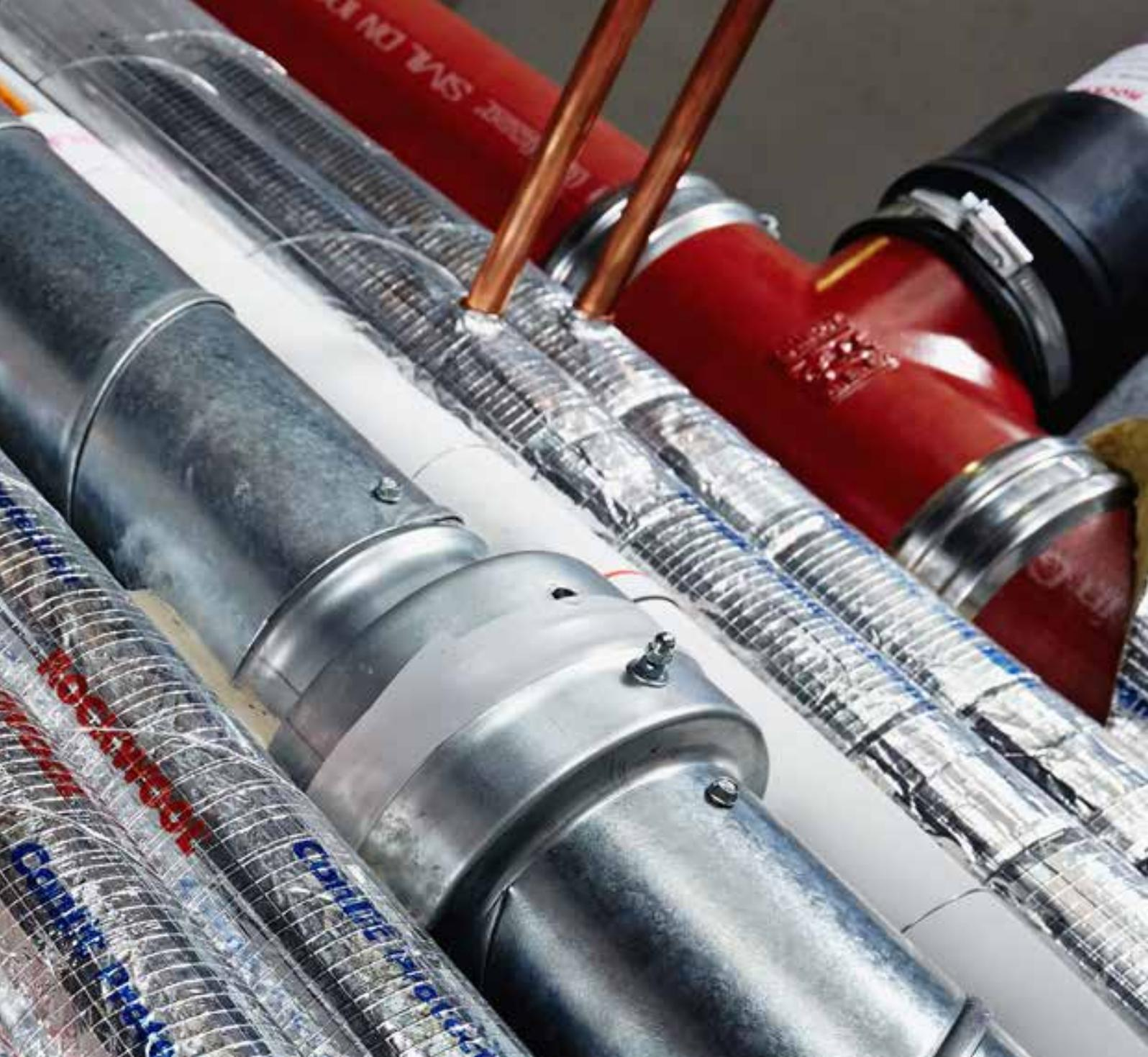
auf Gebäudegröße und deren Nutzung beruhen, ein entsprechendes Brandschutzniveau gewährleistet werden. Brandabschottungen verhindern eine Ausbreitung von Feuer und Rauch und erfüllen beim Conlit Abschottungssystem außerdem die Anforderungen an den Wärme- und Schallschutz.
